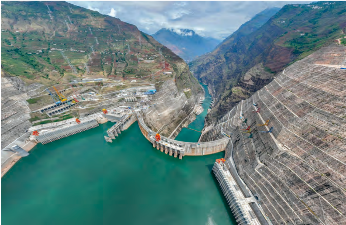
白鹤滩水电站
