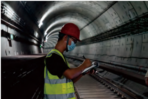
记录隧道盾构环数
